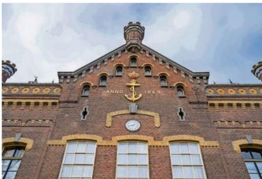
Een van de gebouwen van het KIM in Den Helder.
