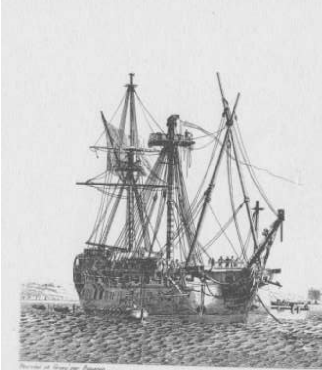
Fig. 3.3 Voorbeeld van een bok takel voor het plaatsen van een mast
