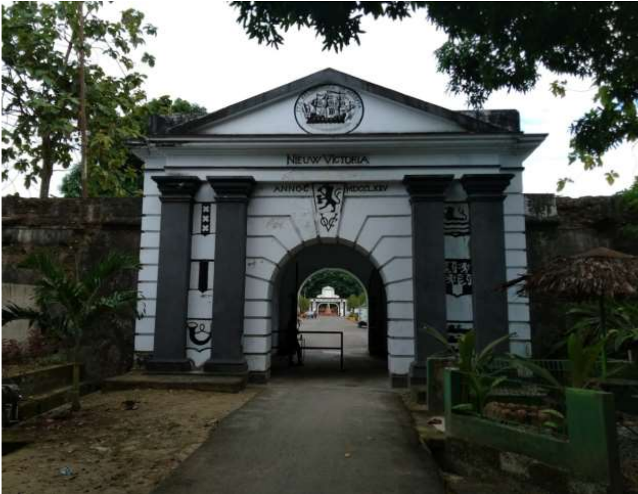
Figuur 6.10.8 De ingang van het Fort Nieuw Victoria op het eiland Amboina zoals het er tegenwoordig uit ziet. Het is gerestaureerd en wordt gebruikt door het Indonesische leger.
