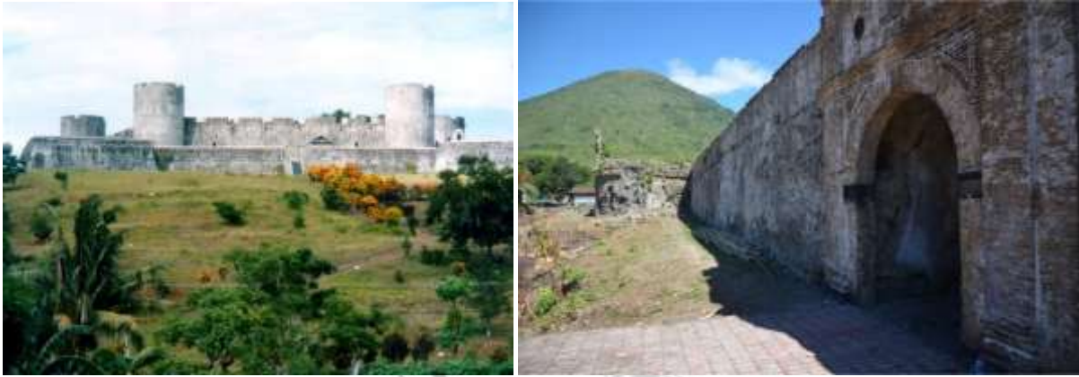
Figuur 6.10.11 a en b; Linksboven, het fort Belgica zoals het er tegenwoordig uitziet, en rechts de muren van het fort Nassau dat in minder goede staat is. Op de achtergrond is de Goenoeng Api te zien. Van het fort Hollandia op Groot Banda is alleen nog een ruïne over.
