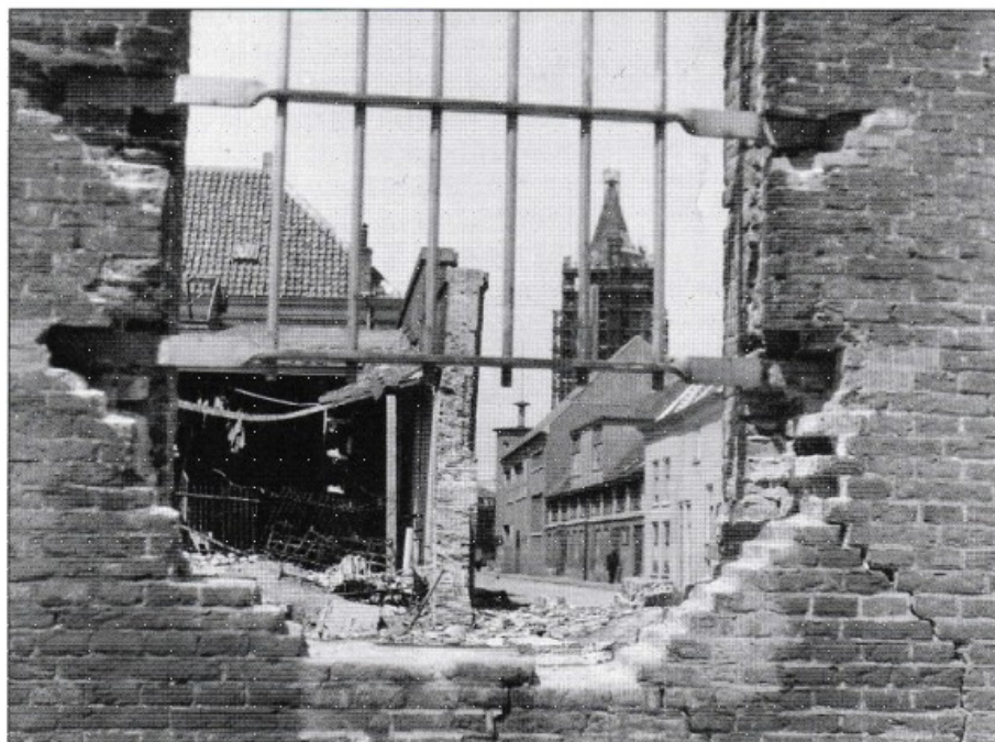
De dubbele affuitloods van het Arsenaal werd op 4 november 1944 tijdens een luchtaanval verwoest. In 1950 kwam er een garage ten behoeve van de genie voor in de plaats (foto uit 1945).
