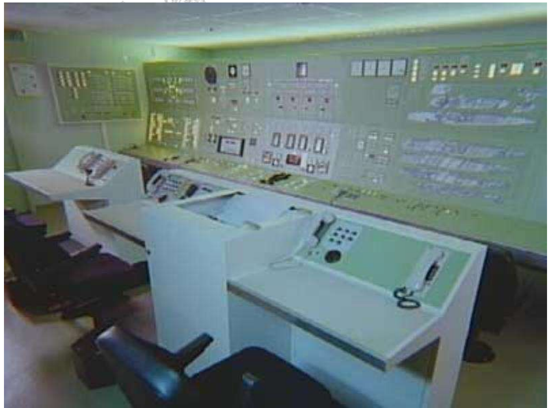
Technische opleiding TDE en TDW op het TOKM op de Marinekazerne Amsterdam. Trainer voor de Technische Centrale a/b van fregatten Het is meer dan een De Mock-up. Hier leerde je de procedures en noodmaatregelen De centrale is ingericht als bij een GW fregat
