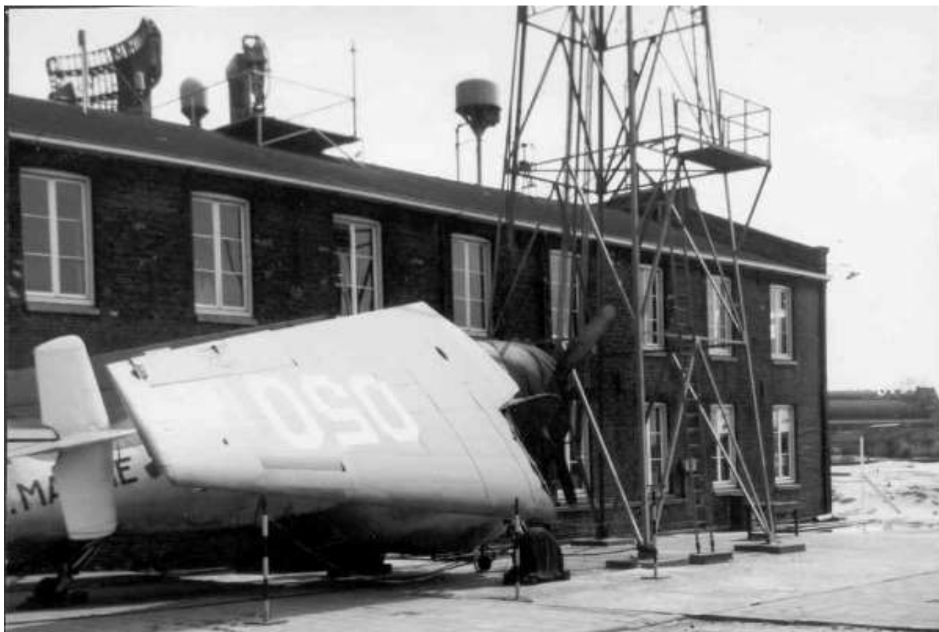
De radio-radar school op het terrein van de TOKM. Naast het schoolgebouw staat een Grumman Avenger TBM-3W2 met registratie 050 (ex P-110). Deze heeft dienst gedaan bij de MLD van 29-09-1953 tot 30-07-1960. Rechts op de achtergrond zien we reeds het opgespoten zand voor de uitbreiding van de TOKM.
