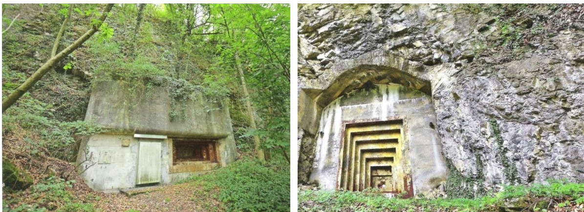
Batterij Oost, schietopeningen en nooduitgangen
