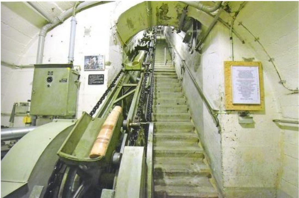
Munitielift naar een der geschutstorens
