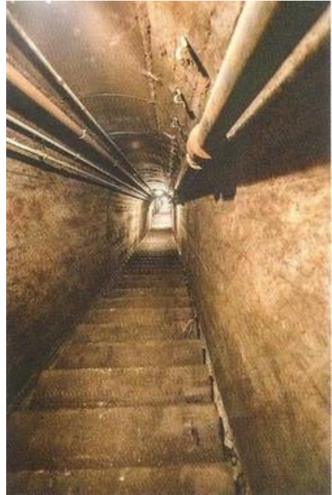
Trap naar Katzenbunker
