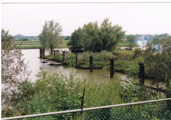
Caissonhaven in Arnhem, oktober 1993
