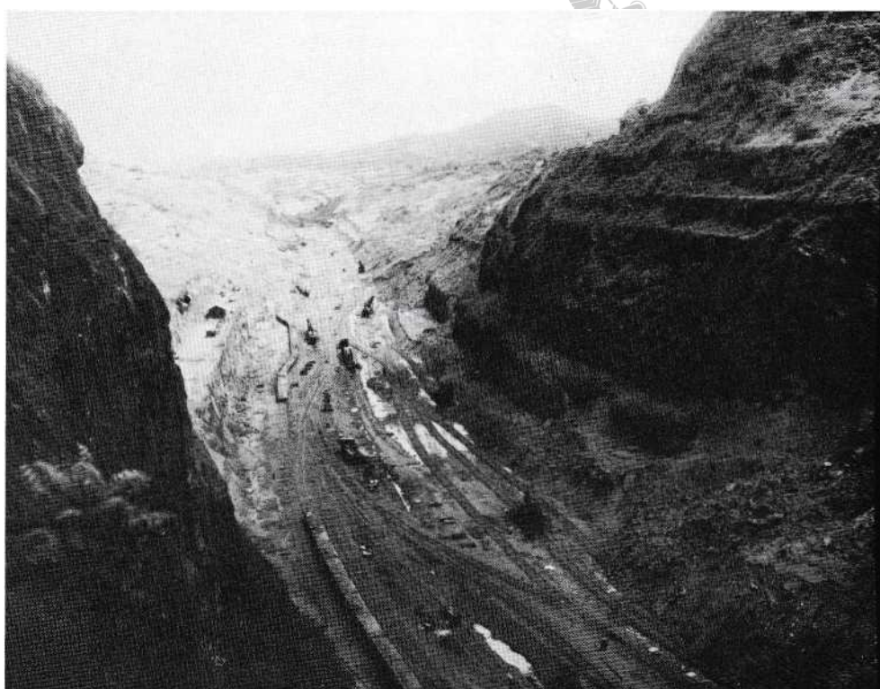
De werkzaamheden bij de Gaillardengte in juni 1913. Een recordmaand was maart 1912; men haalde toen met 3217 treinstellen 65.555 wagons grond weg!
