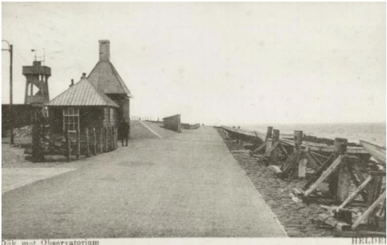
Dijk met Observatorium
