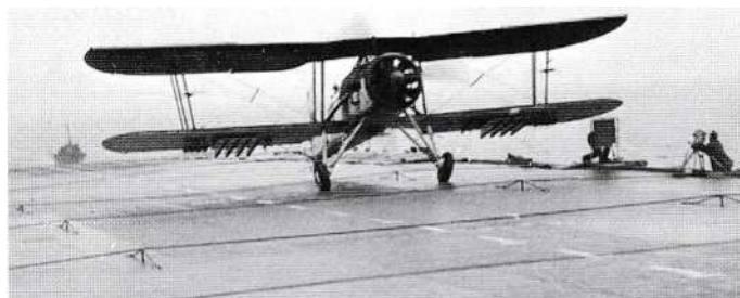
Een geslaagde deklanding van een Fairey Swordfish-toestel op het dek van het MAC-schip „Macoma” in mei 1944 tijdens de proeftocht na de verbouwing in de Schotse wateren. Foto Marvo; via L.L. von Münching.
