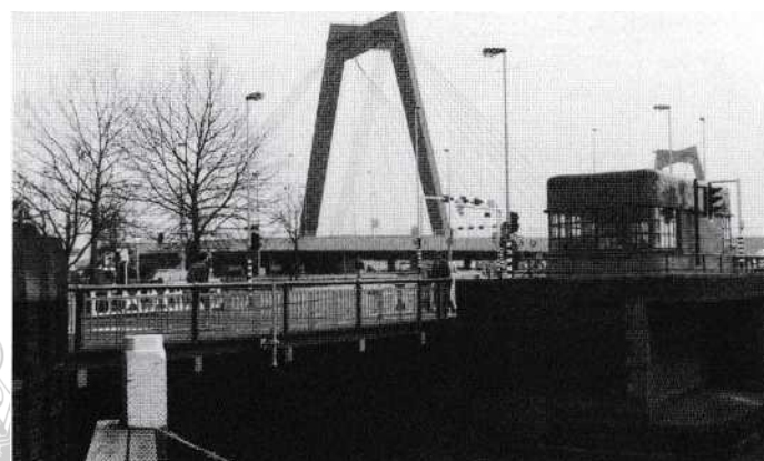
De nieuwe Willemsbrug, op de voorgrond de Jan Kuytenbrug met brugwachtershuisje, beide uit 1931.
