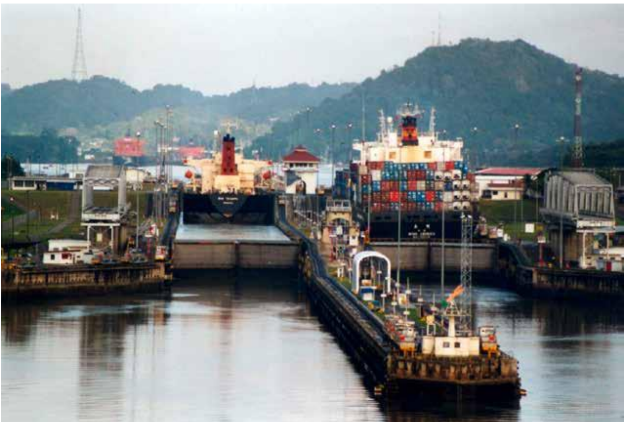
De Miraflores sluizen, bestaande uit 4 sluiskolken, parallel naast elkaar, waardoor er twee grote schepen tegelijk kunnen worden geschut. Waterniveau overbrugging ca. 17,3 meter. Dicht bij deze sluizen bevinden zich de Pedro Miguel sluizen.
