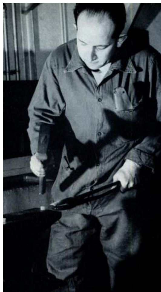
Ook het smeden is een onderwerp wat de Korporaalmachinist onder de knie moet krijgen. Kpl.mach. H.A. van Ormel met het smeden van een beitel.
