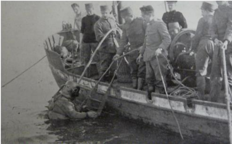
Duiker van de torpedisten gaat te water om een explosieve lading aan te brengen
