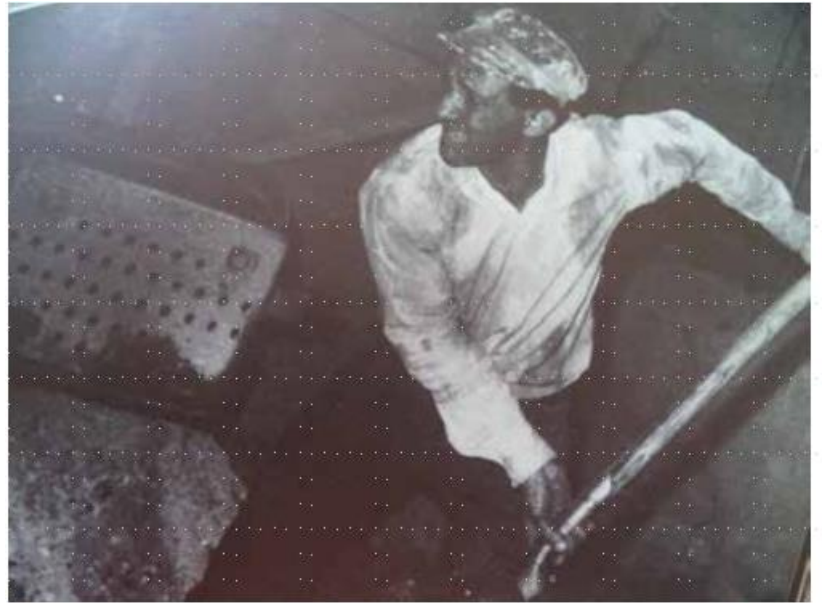
Stoker werpt steenkolen in een vuurgang van een Schotse ketel. Foto: afkomstig van het boek 'the British Seafarher' (geen copyright gebaseerd op BBC programma)
