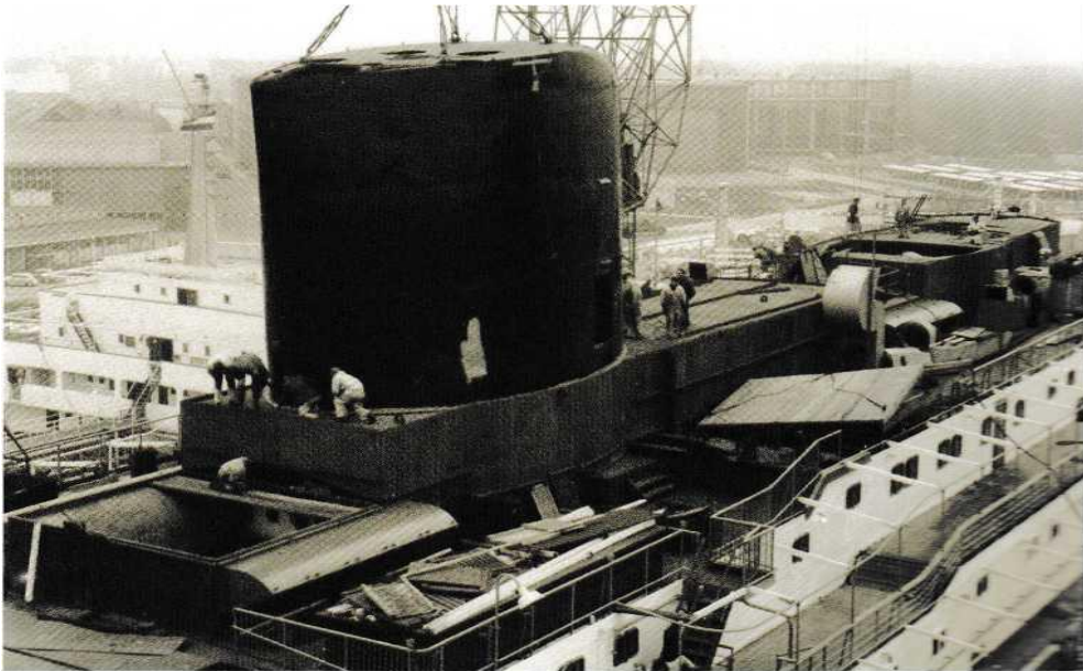
De vernieuwde achterste schoorsteen van de 'Willem Ruys' wordt gemonteerd.
