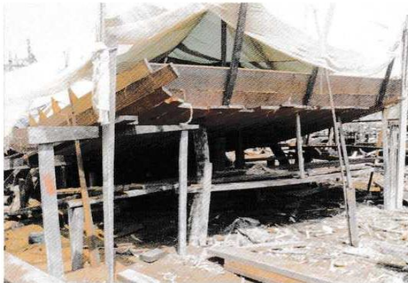
De vorm van het achterschip wordt al duidelijk zichtbaar.
