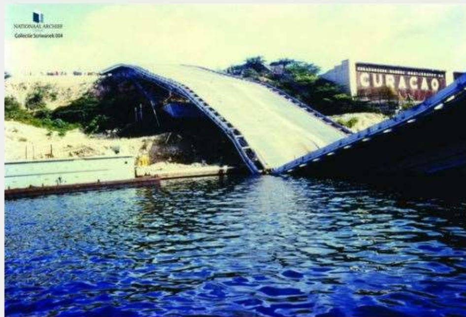
De ingestorte Julianabrug in 1967. © RV
