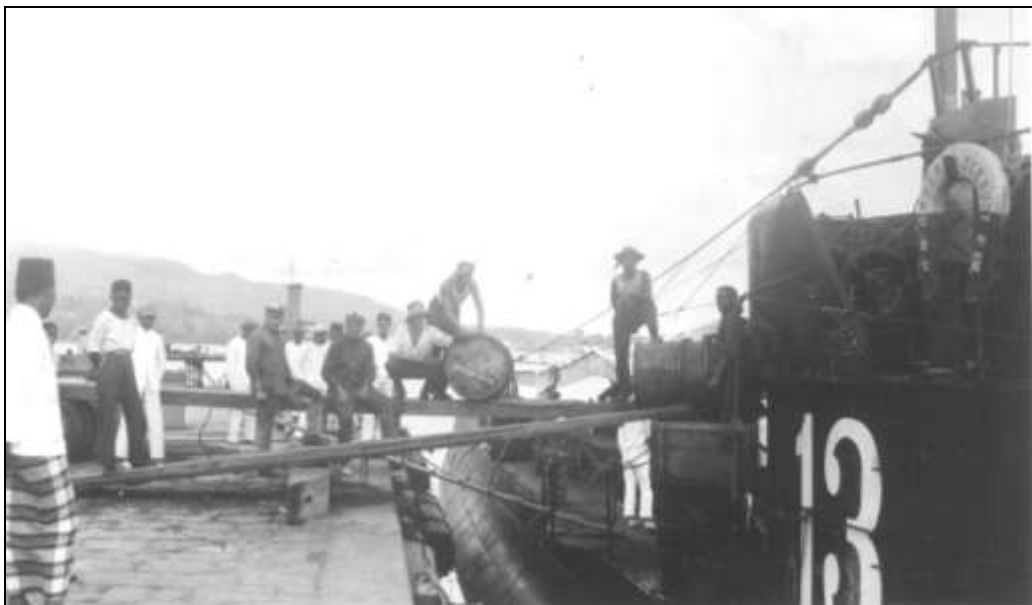
Boven de trechter wordt een bak opgetuigd en de vaten de plank opgerold en boven de bak geledigd en langs de andere plank de wal weer opgerold.
